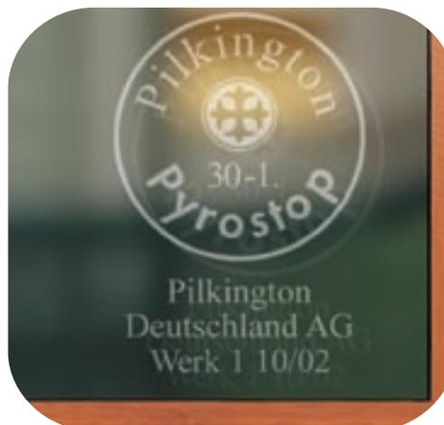
– Bild links – Systemkennzeichnung: Jede bauaufsichtlich zugelassene Brandschutz-Systemkonstruktion ist mit einem Typenschild zu kennzeichnen.
