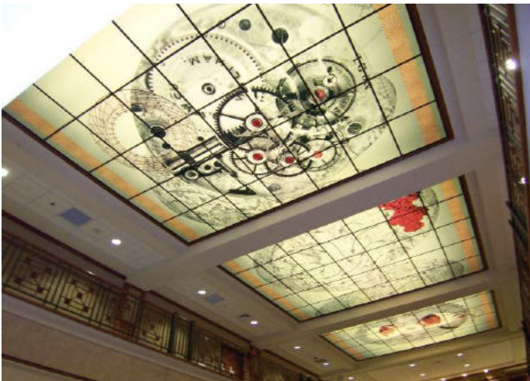
Lichtdecke, von oben beleuchtet, Universität Madison, USA
