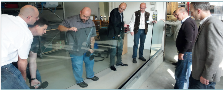
Montageübung: hier wurde der Einbau der Geländersysteme praktisch eingeübt.
